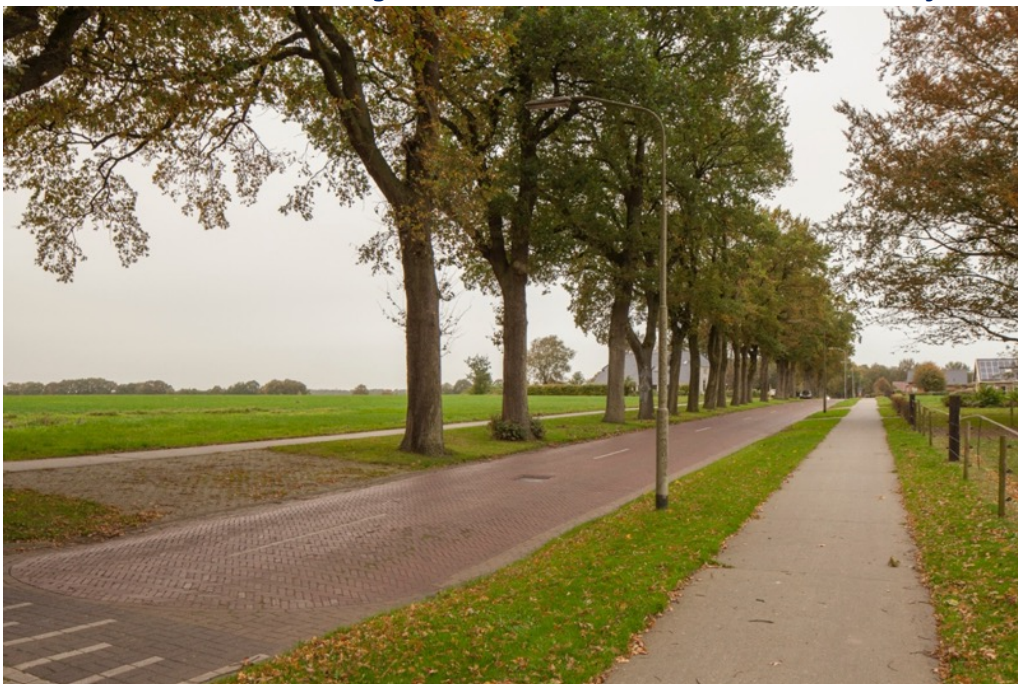
Foto: Borgerderstraat in Ees, doorgaand fietspad los van de rijbaan.
