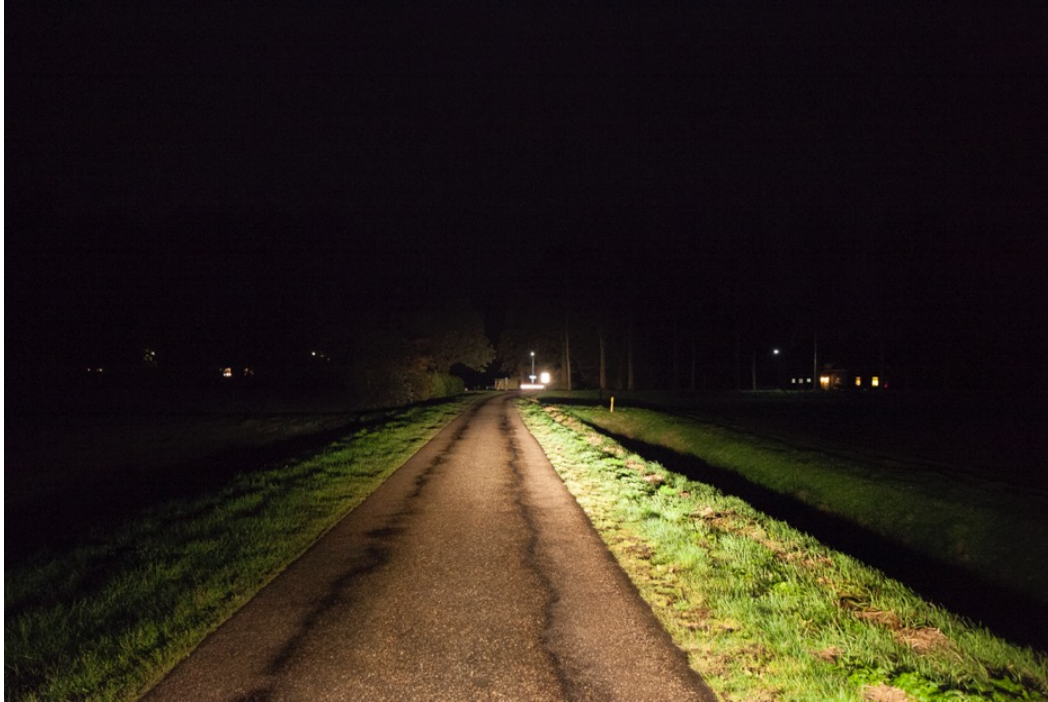
Foto: Osdijk in Buinerveen. Schrikhek is aan het einde van de weg van veraf al zichtbaar en de lantaarnpaal nog niet.
