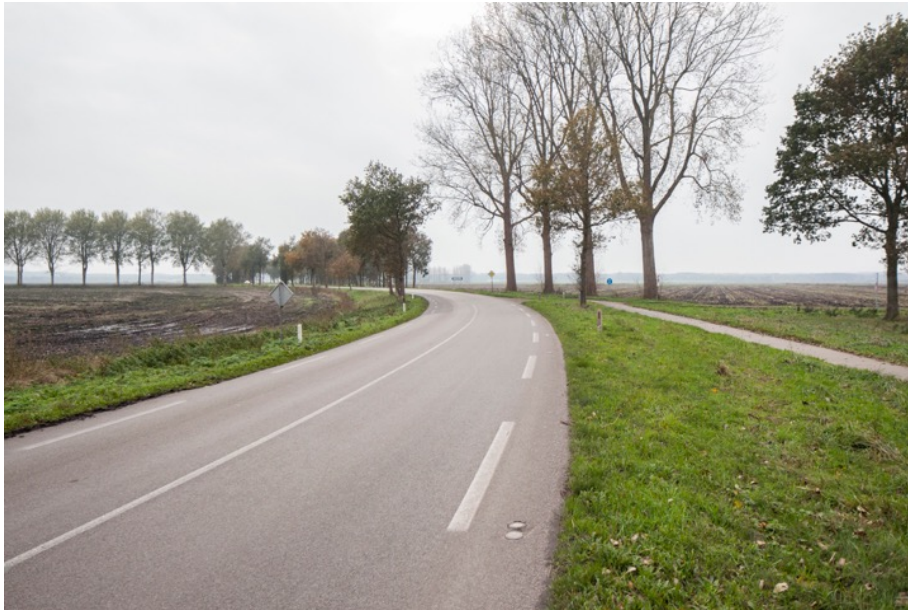
Foto: Oude Dijk in Exloërveen, lampjes aan de zijkant van de weg op zonne-energie.
