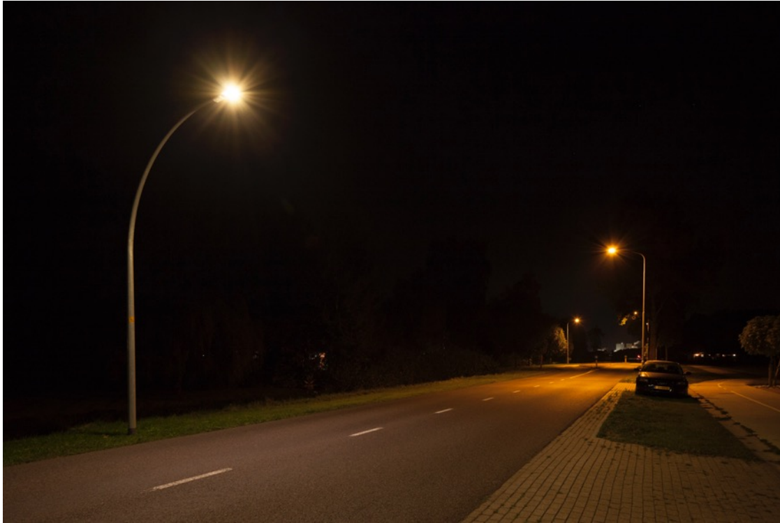
Foto: N379 Drouweniermond. Twee kleuren licht. Voorgond wit licht met goede kleurherkenning en achterin oranje licht die geen goede kleurherkenning geeft.
