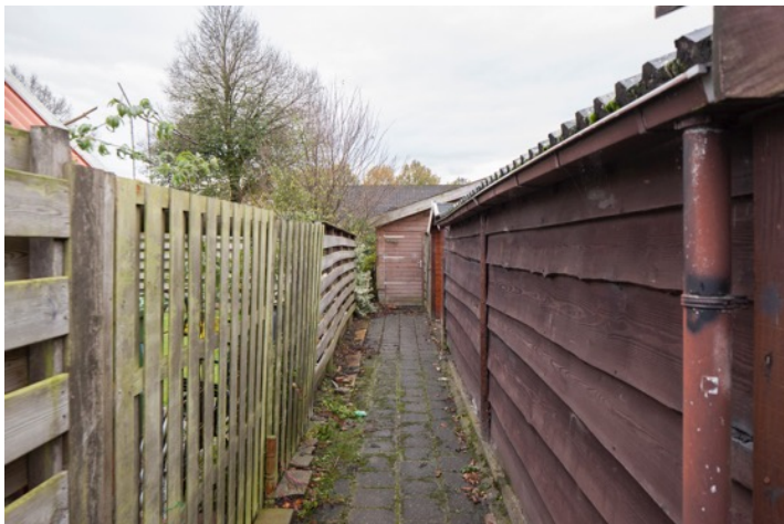
Foto: Harm Tiesingstraat in 2 e Exloërmond, Achterpad niet verlicht.
